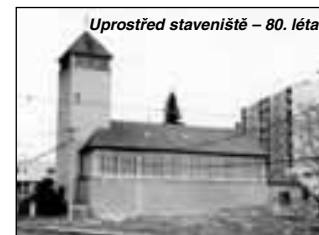
Uprostřed staveníště – 80. léta
